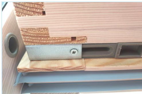
OKNO NIEZABLOKOWANE - - zasuwka schowana
