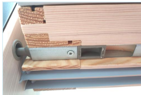
OKNO ZABLOKOWANE - - zasuwka wysunięta
